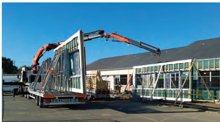
Pose des modules bois sur chantier
