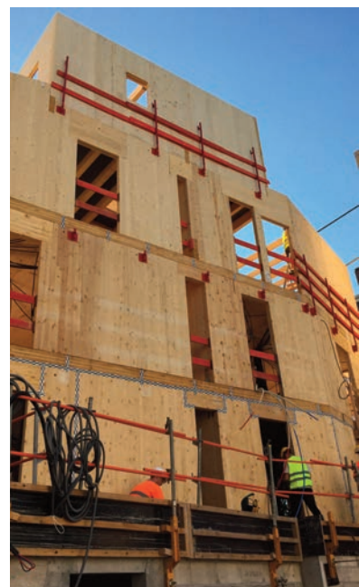
Murs extérieurs avec pose du scotch d'étanchéité à l'air
