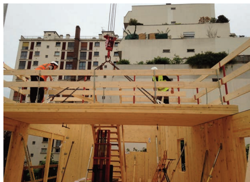
Pose d'un élément de plancher par 2 compagnons LCA aidés d'une grue araignée
