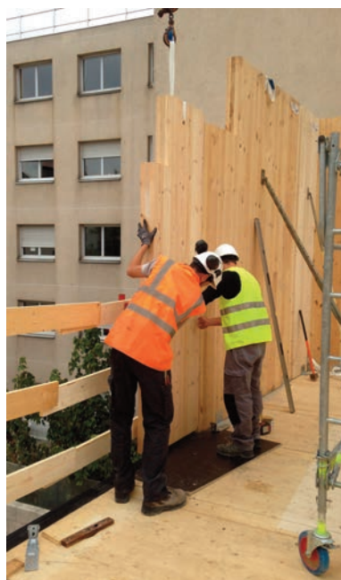
Pose de panneaux bois par 2 compagnons LCA
