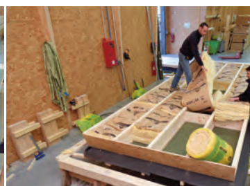
Pose de l'isolant
