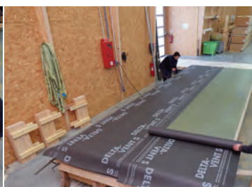
Pose de l'écran de sous-toiture
