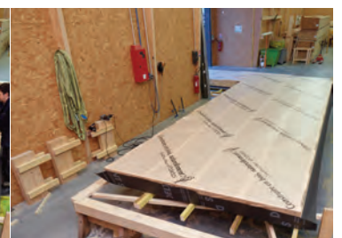
Pose du pare-vapeur
